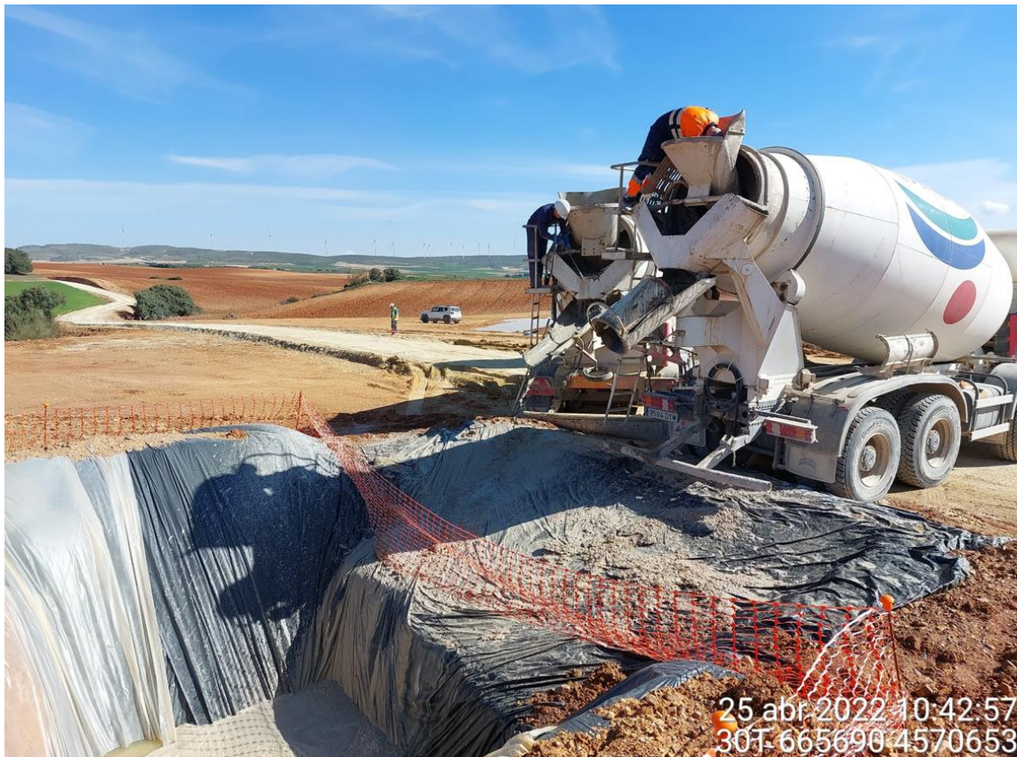
Imagen 2. Lavado de cubas de hormigón en el pozo de lavado en SBII-08.
