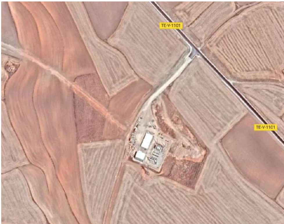
Figura 2: Subestación eléctrica sobre foto aérea
