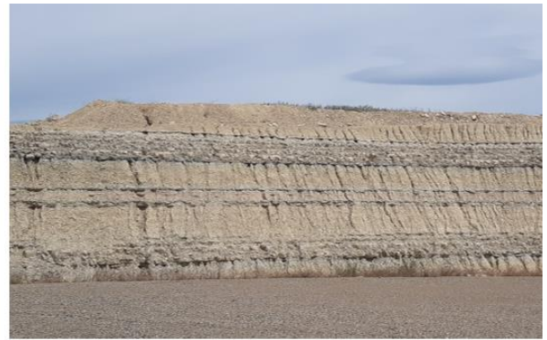
Fig. 8 Erosión hídrica en materiales margo-lutíticos del talud de desmonte de plataforma del aero ML4.05. Fuente: Elaboración propia
