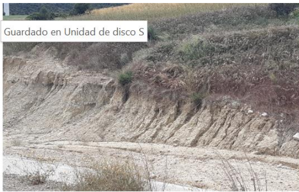
Fig. 7 Erosión hídrica en materiales margosos del talud de desmonte del vial de acceso al aero ML4.03. Fuente: Elaboración propia
