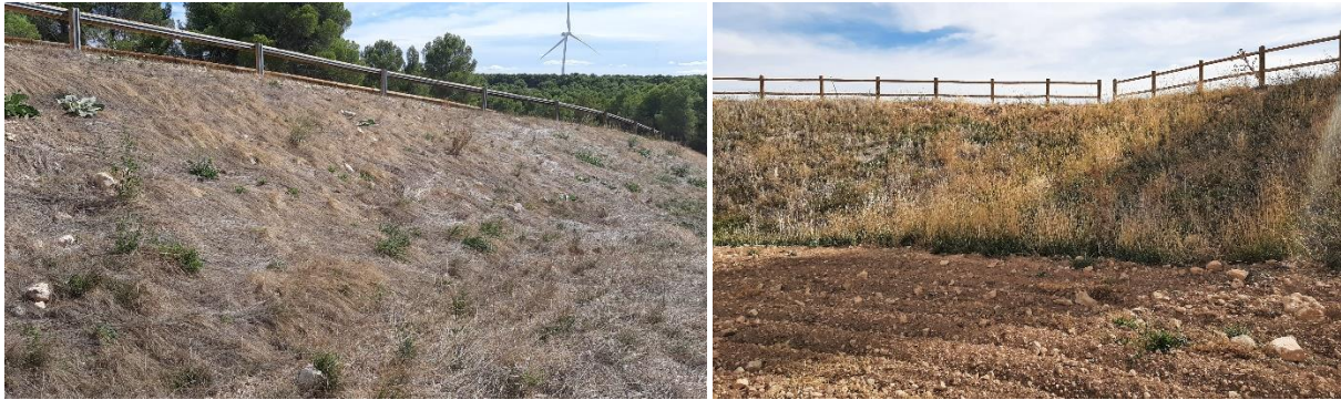
Revegetación en los taludes de LG-03 (izquierda) y LG-01 (derecha)
