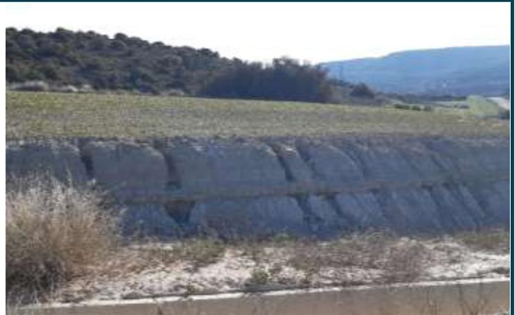
Fig. 2 Erosión hídrica en materiales margo-calizos del talud de desmonte del vial de acceso al aero LSA.07. Fuente: Elaboración propia
