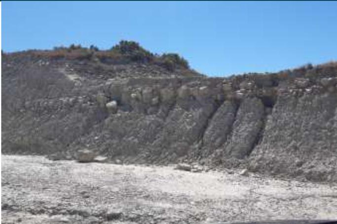
Fig. 1 Erosión hídrica en materiales margosos del talud de desmonte del vial de acceso al aero LSA.10. Fuente: Elaboración propia
