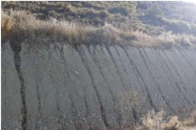
Fig. 3 Erosión hídrica en materiales margosos del talud de desmonte del vial de acceso al aero LSA.03. Fuente: Elaboración propia
