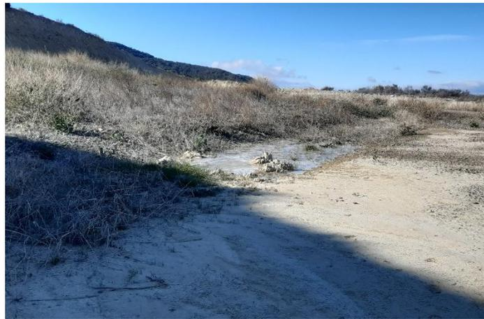
Fig. 3 Encharcamiento en margen de plataforma del aero LSA.01. Fuente: Elaboración propia
