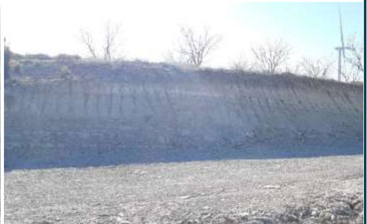
Fig. 4 Erosión hídrica en materiales margosos del talud de desmonte del vial de acceso al aero LSA.01. Fuente: Elaboración propia
