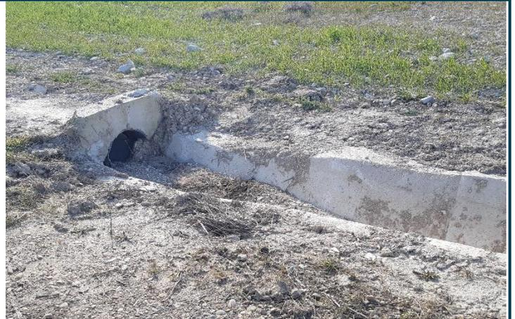
Fig.2 Tubo de drenaje taponado por sedimentos en vial de acceso al aero LSA.01. Fuente: Elaboración propia
