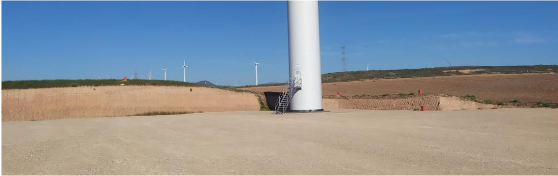
Figura 20: Taludes de la plataforma de ET11 en correcto estado de conservación.
