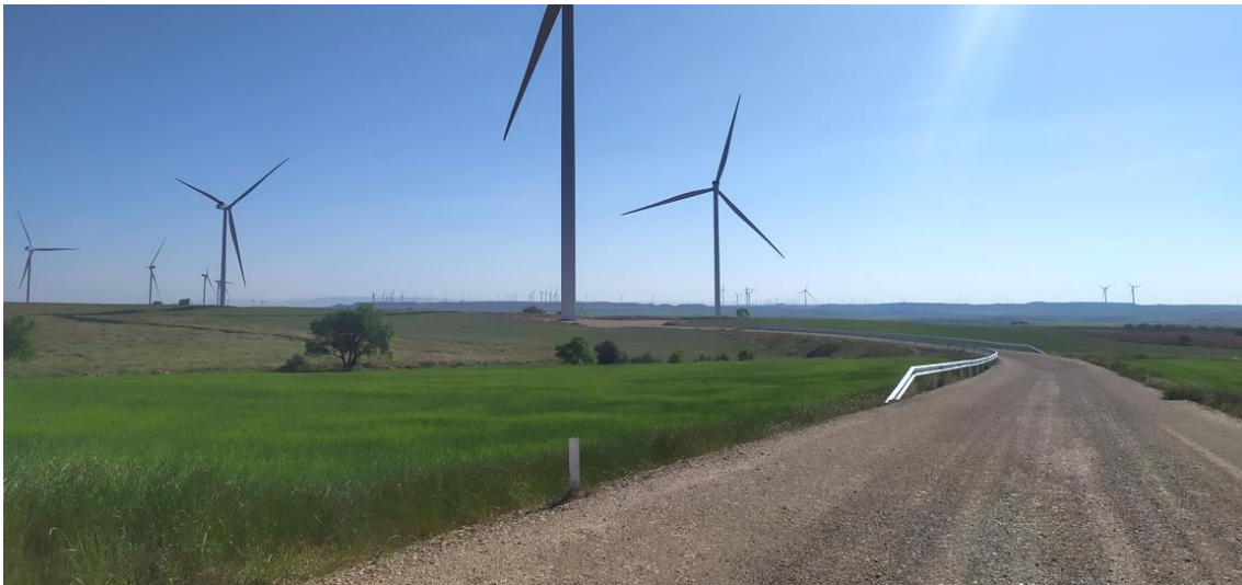
Figura 22: Vial de acceso al aerogenerador ET1. Puede observarse que los taludes laterales han comenzado a ser cubiertos por la vegetación natural.
