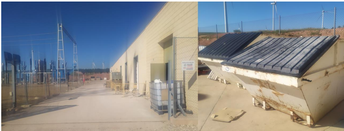
Figura 31: La SET Los Visos (PE Los Visos) ha sido la infraestructura asociada al PE El Tollo respecto a gestión de residuos.
