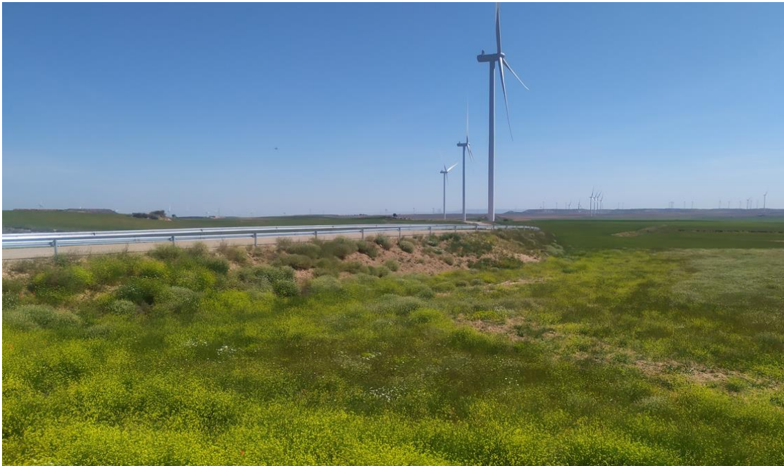
Figura 23: Vial de acceso principal entre aerogeneradores ET8 (aerogenerador más cercano de la imagen) y ET7. Puede observarse la vegetación natural arbustiva creciendo en los taludes.
