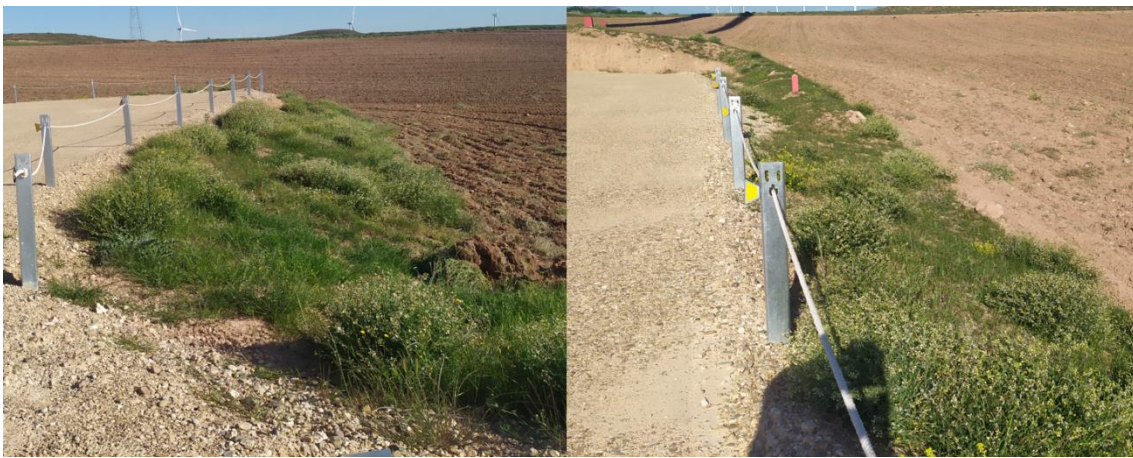
Figura 21: Vegetación natural creciendo sobre los taludes de menor pendiente de ET11.
