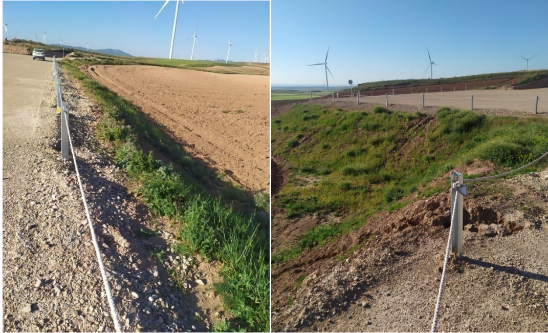
Figura 18: Taludes del aerogenerador ET12 con crecimiento espontáneo de vegetación natural.
