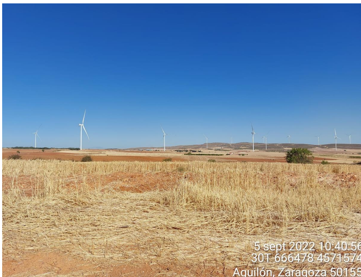
Imagen 1. Fotografía general del parque.
