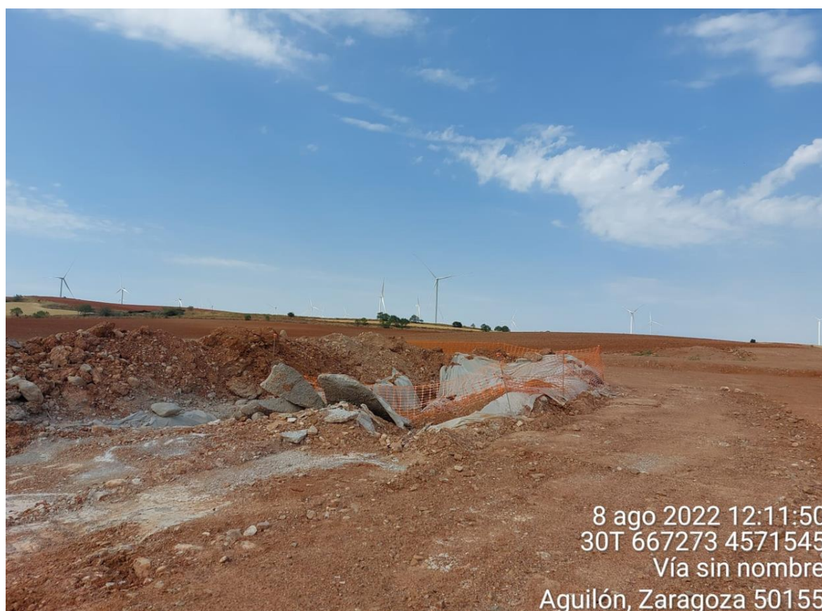
Imagen 1. Pozo de lavado sin restaurar.
