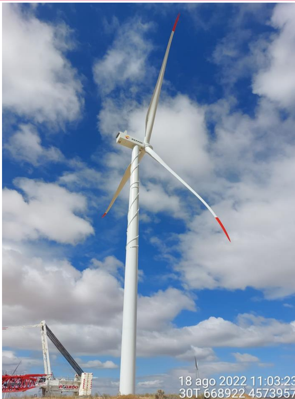
Imagen 2. Aerogenerador en fase de montaje.
