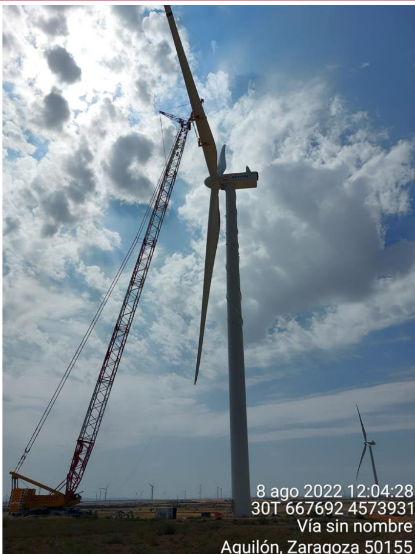
Imagen 3. Montaje aerogenerador.
