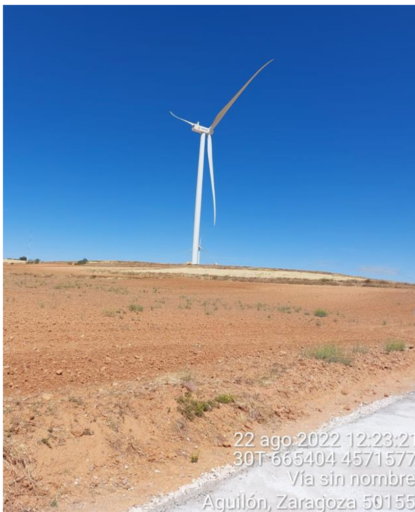
Imagen 1. Vista del aerogenerador SBII-02.
