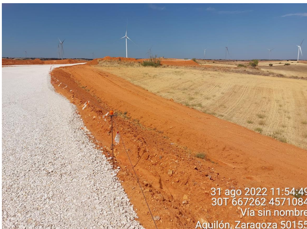
Imagen 1. Posición PLX-02 durante la visita de restauración.
