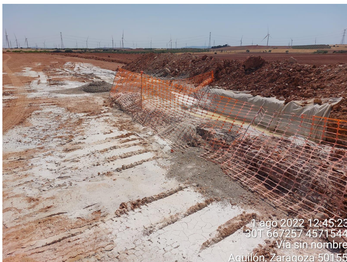
Imagen 1. No conformidad grave. Pozo de lavado sin impermeabilizar correctamente y suelo contaminado en PLX-1.
