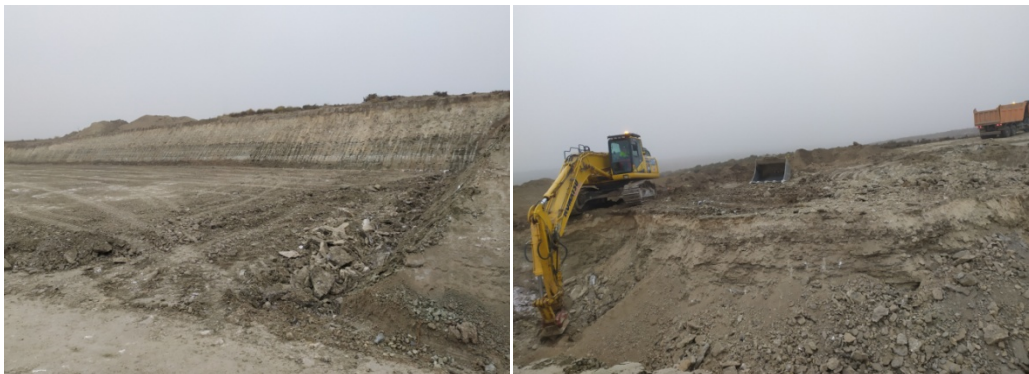
Foto 21. Excavación para nivelar la plataforma del aerogenerador 2 (16/12/2022)
