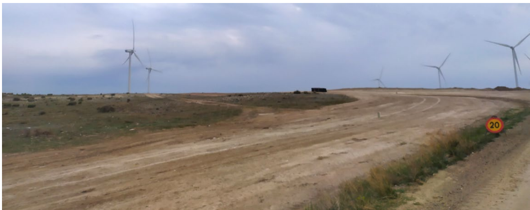
Foto 29. Vial de acceso en el cruce de aerogeneradores 2 y 3 ya restaurado.
