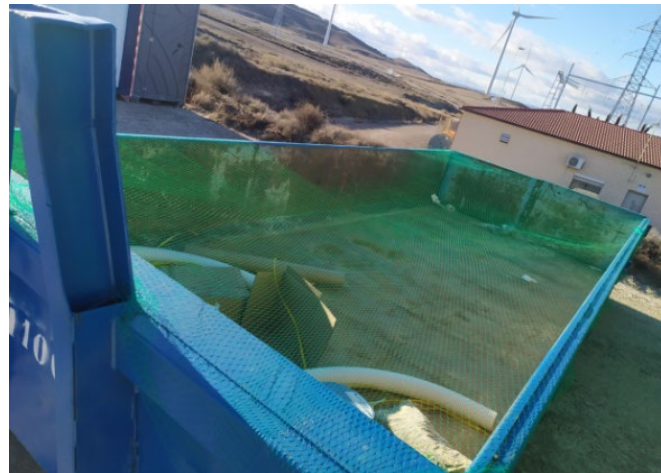
Foto 13. Malla de sujeción colocada sobre el contenedor de residuos sólidos urbanos
