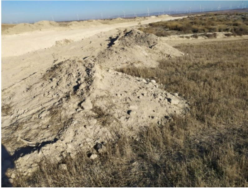
Foto 5. Acopio de tierra vegetal localizado sobre terreno de cultivo, evitando así acopiarse en las secciones de terreno natural como se observa en la sección superior derecha de la fotografía.
