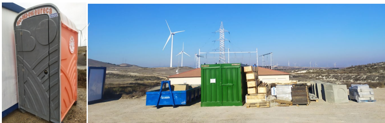
Foto 2. Site Camp ya establecido (fotografía del 26-1-2022). Se muestra de izquierda a derecha parte de la casa de contratas y el servicio portátil tras la misma, el contenedor de residuos sólidos urbanos, el almacén de residuos peligrosos situado en un contenedor verde, el acopio de residuos de madera y material de obra.
