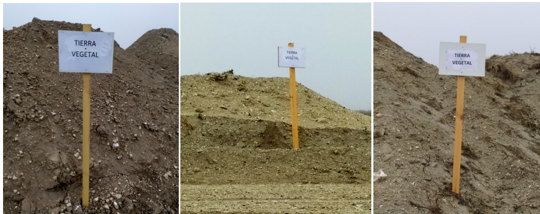
Foto 19. Carteles colocados para señalar los acopios de tierra vegetal a lo largo de la obra
