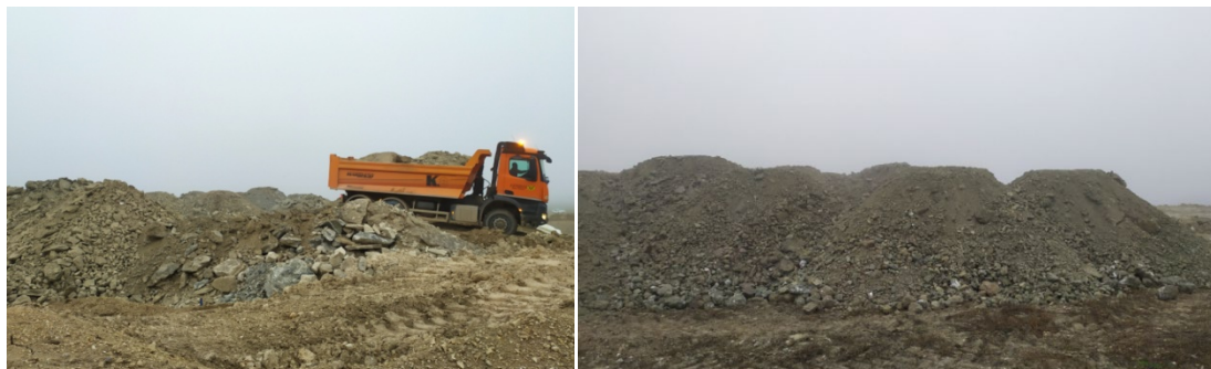
Foto 24. Ejemplos de acopios de tierra mineral sobre las plataformas.
