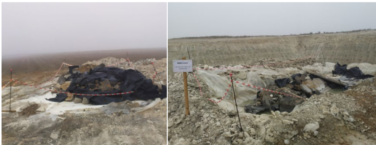
Foto 28. Residuos de hormigón almacenados en las piscinas de lavado de las plataformas.
