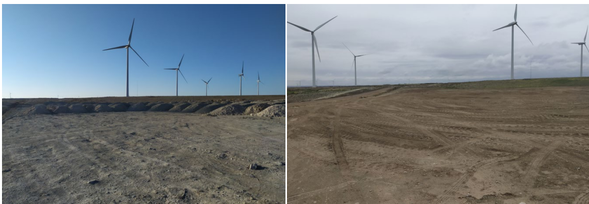
Foto 30. El campo de cultivo que se empleó de acopio de tierra mineral y vegetal (norte de la plataforma del aerogenerador 3) ha sido restaurado correctamente y recubierto con la tierra vegetal original. A la izquierda se muestra una foto antes de la restauración y a la derecha tras la restauración.
