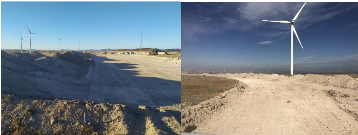
Foto 18. Ejemplos de acopios de tierra vegetal en plataforma del aerogenerador 3 y a lo largo del vial de acceso al aerogenerador 1 y 2.
