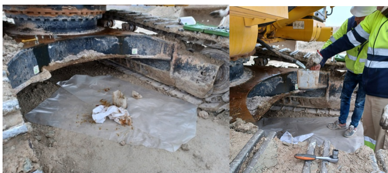
Foto 11. Fuga de aceite de uno de los vehículos de obra siendo limpiado y retirado de la zona de obra (21/12/2021).
