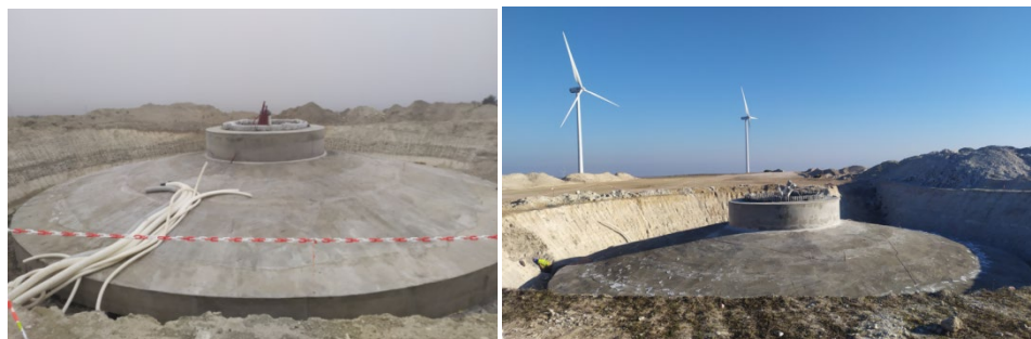
Foto 27. Cimentaciones del aerogenerador 2 (izquierda) y 3 (derecha) ya completadas el día 9/2/2022.
