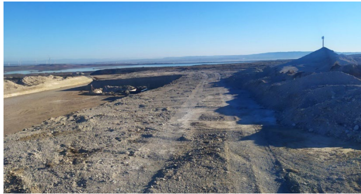
Foto 8. Parte superior del talud al sureste de la plataforma 2, ya terminadas las labores de enterramiento de cables y a punto de ser restaurado el 23 de febrero de 2022. Para la restauración se empleó el acopio de tierra vegetal que puede observarse a la derecha de la fotografía.
