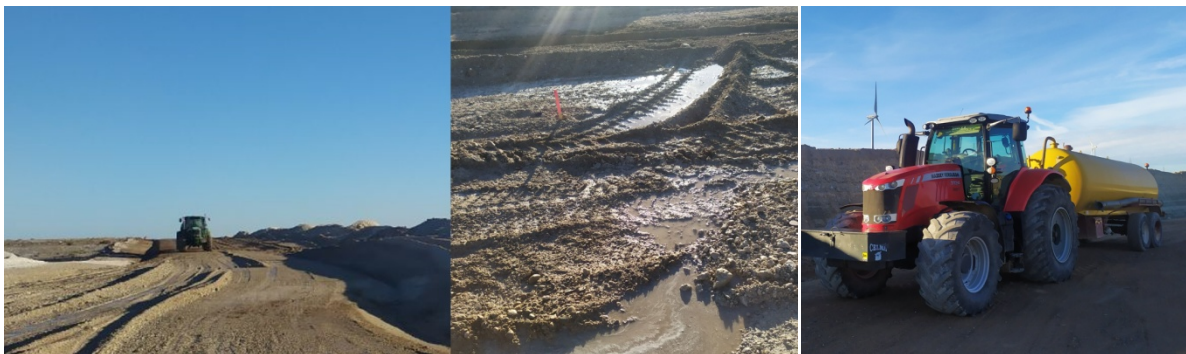
Foto 4. Riego de la superficie del vial de acceso a la obra de los futuros aerogeneradores 1 y 2 durante el 18/11/2021, y tractor con cisterna de riego aparcado en plataforma de aerogenerador 2.
