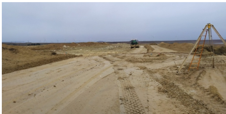
Foto 22. Nivelado de la plataforma del aerogenerador 1 (9/12/2021).
