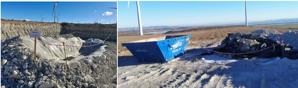
Foto 15. Piscinas de limpieza de hormigón. A la izquierda la piscina situada en la plataforma 2 antes de ser empleada, con su cartel de señalización, y a la derecha la piscina de la plataforma 3 con los residuos de hormigón almacenados preparada para ser finalmente retirada en un contenedor metálico.
