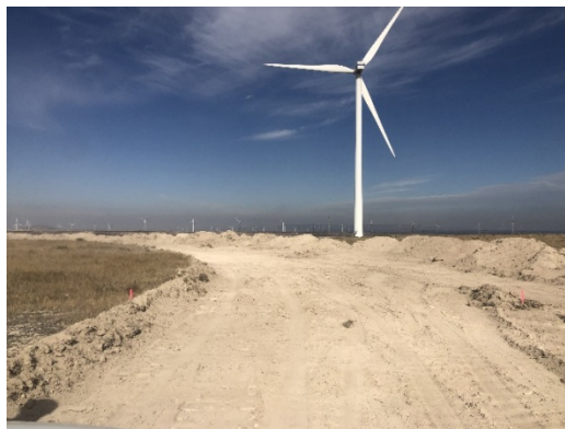
Foto 17. Comienzo de los desbroces y retirada de tierra vegetal (4/11/2021).
