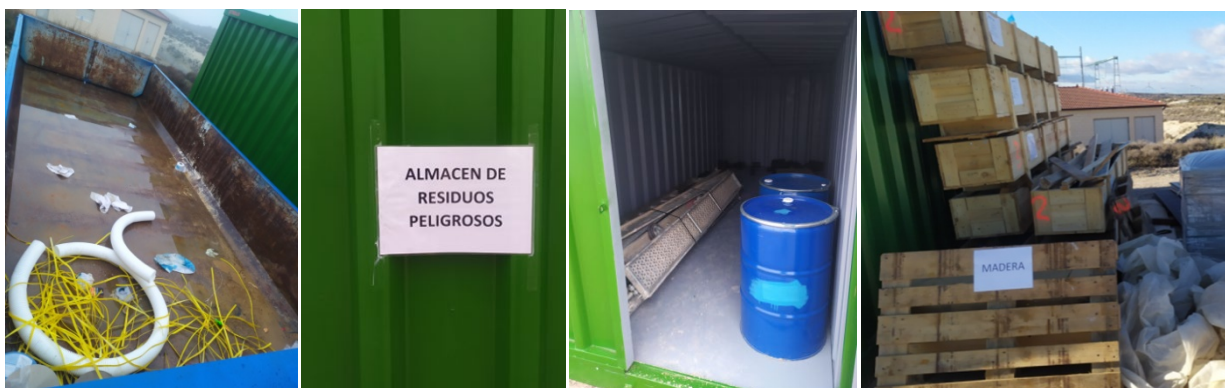
Foto 9. Punto limpio de residuos, mostrando de izquierda a derecha el contenedor de residuos sólidos urbanos, el cartel del almacén de residuos peligrosos, el interior de dicho almacén y el acopio de residuos de madera.
