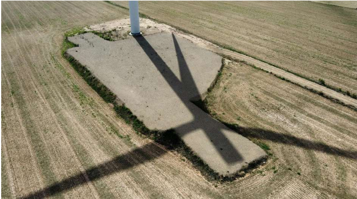
Foto nº3.: Plataforma del Aerogenerador AG-03.
