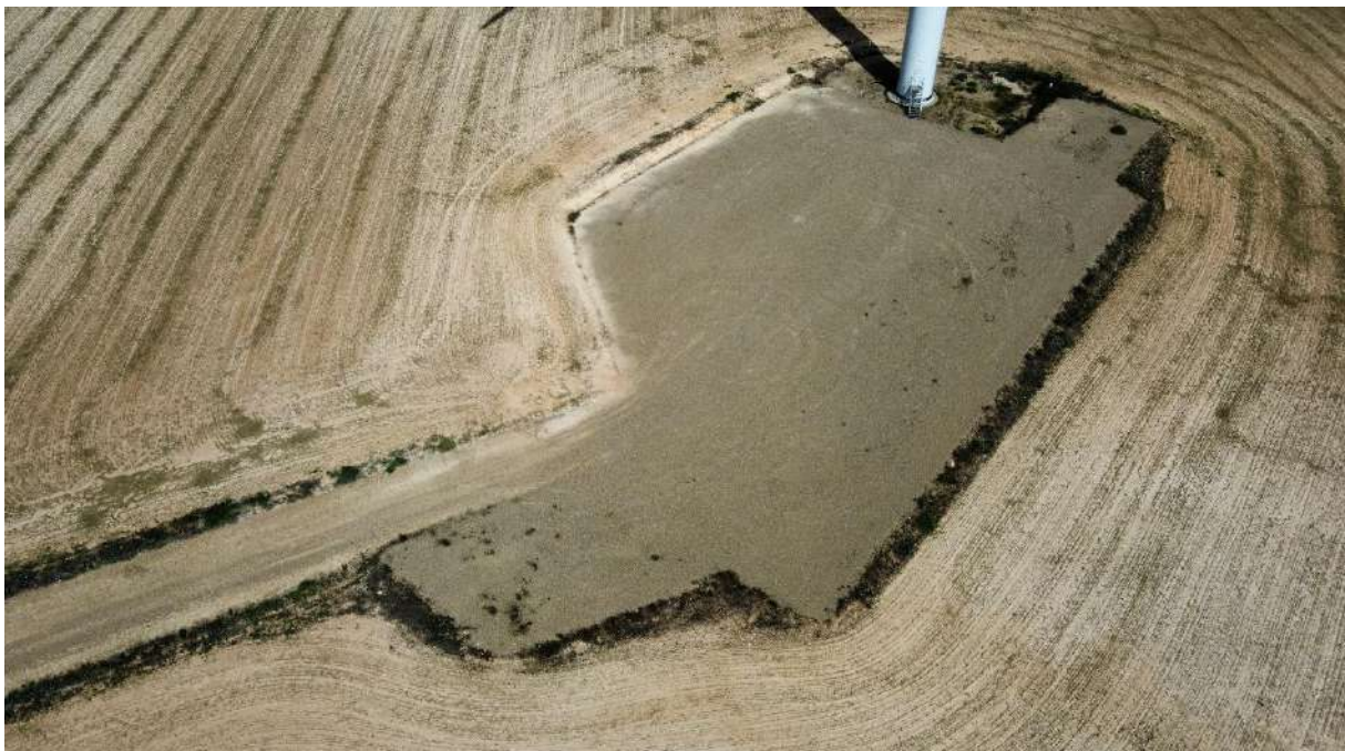
Foto nº2.: Plataforma del Aerogenerador AG-02.
