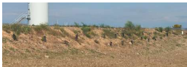
Estado general de los taludes restaurados (AG-07)
