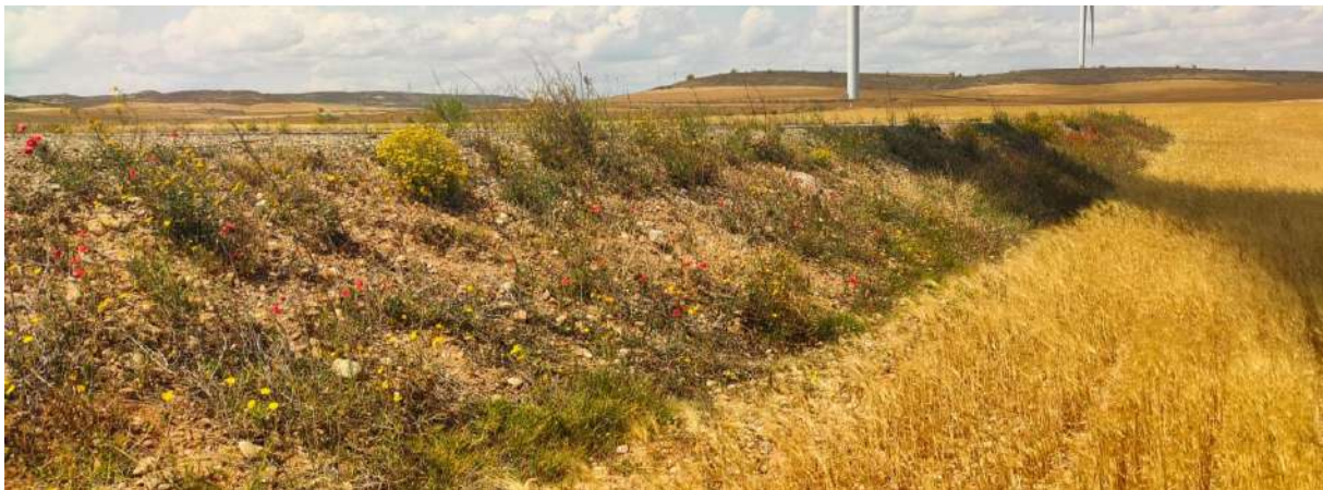
Foto nº12.: Hidrosiembra en terraplén AG-03.
