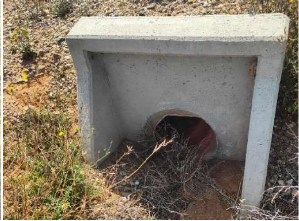
AG-04: Drenaje del vial.
