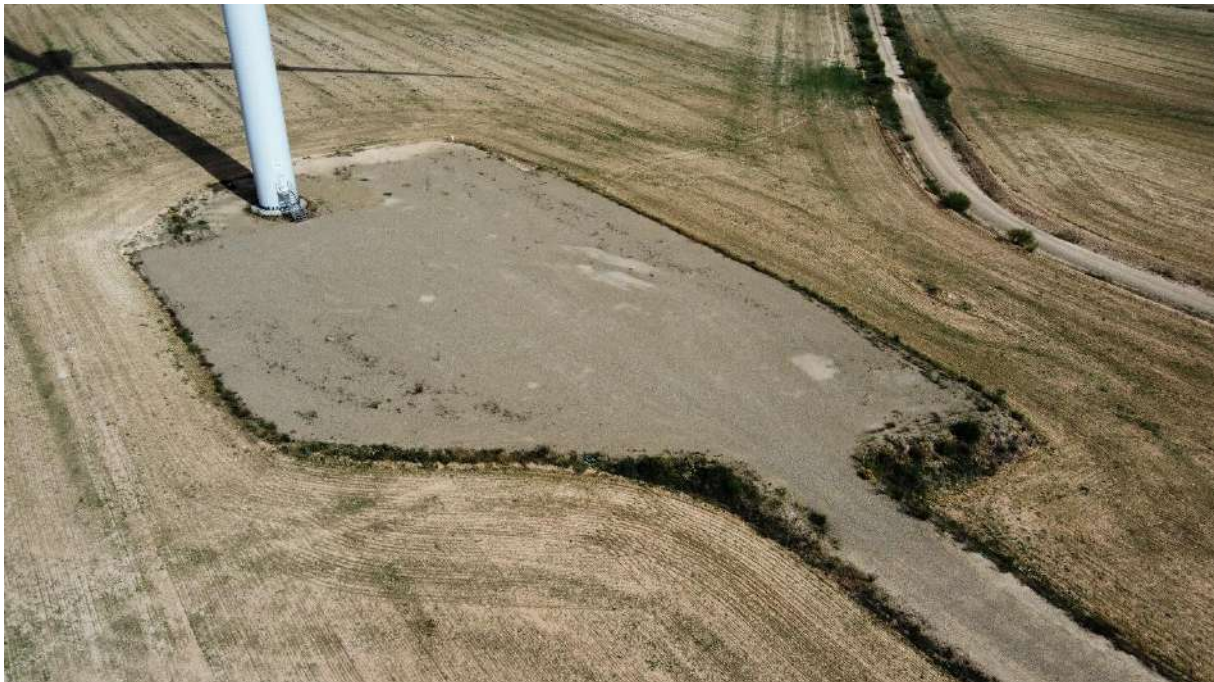
Foto nº4.: Plataforma del Aerogenerador AG-04.
