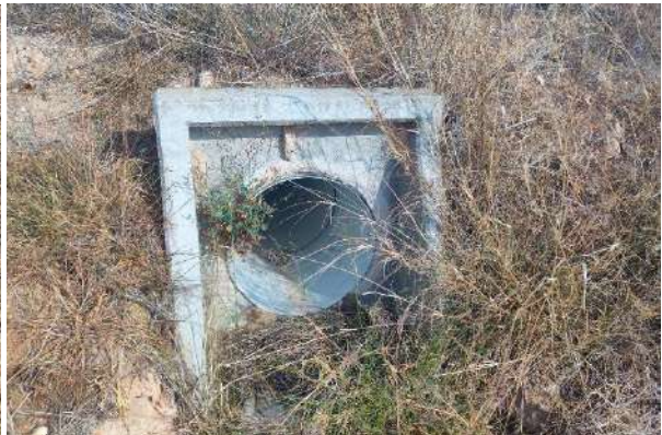
AG-07: Drenaje del vial.
