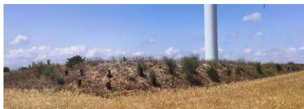
Estado general de los taludes restaurados (AG-04)
