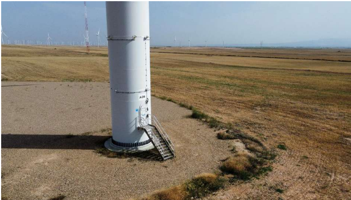
Foto nº10.: Instalación Dispositivo DTBird en aerogenerador AG-09.
