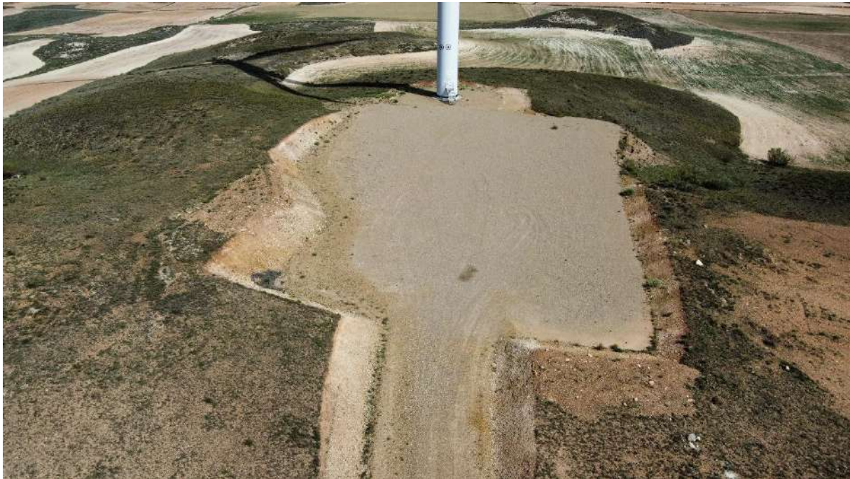
Foto nº1.: Plataforma del Aerogenerador AG-01.
