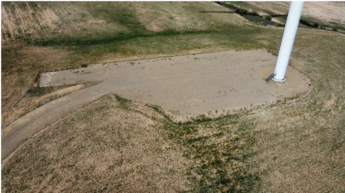
Foto nº6.: Plataforma del Aerogenerador AG-06.
