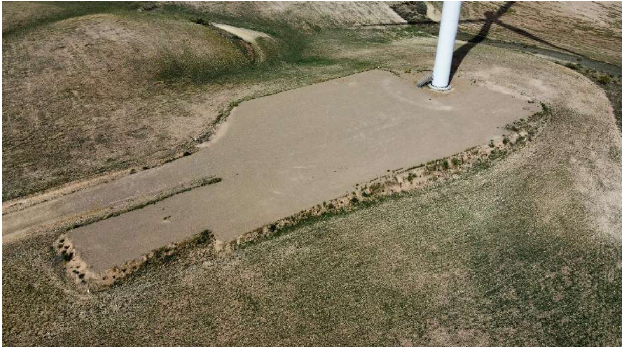
Foto nº7.: Plataforma del Aerogenerador AG-07.
