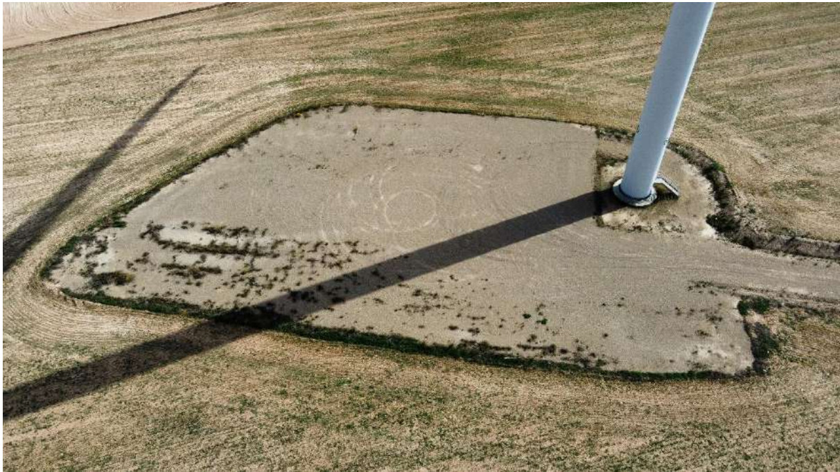
Foto nº5.: Plataforma del Aerogenerador AG-05.
