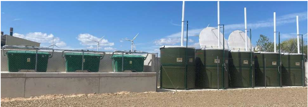
Nuevos contenedores para almacenamiento y autohidrólisis de cadáveres de porcino, ubicados en el núcleo ganadero.
