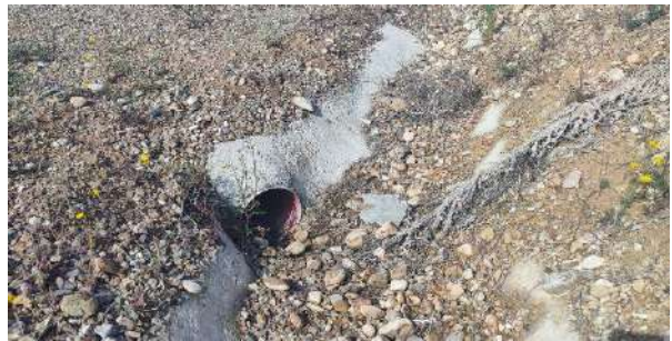
AG-06: Drenaje del vial.
