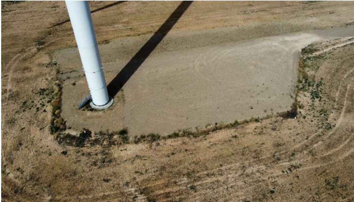
Foto nº9.: Plataforma del Aerogenerador AG-09.
