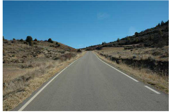
Limpieza cunetas pista asfaltada dirección Navazo
