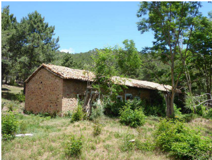
Estado actual del edificio que albergaba cuatro de las antiguas casas de los resineros
