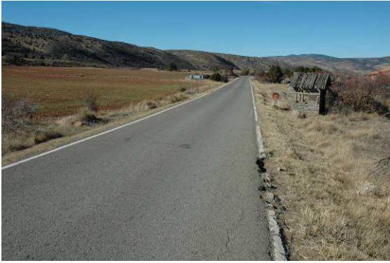
Limpieza cunetas pista asfaltada dirección Albarracín
