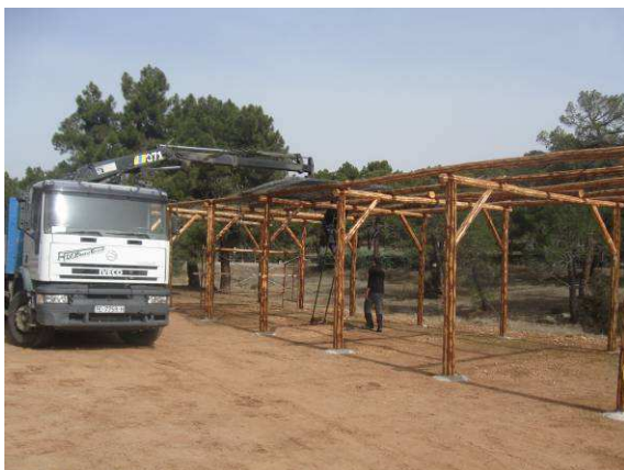
Colocación del mallazo en el aparcamiento del Navazo
