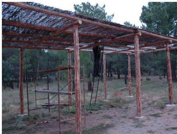
Colocación del brezo en el aparcamiento del Navazo
