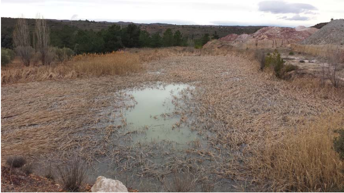
Detalle de la balsa de lodos de la planta de lavado
