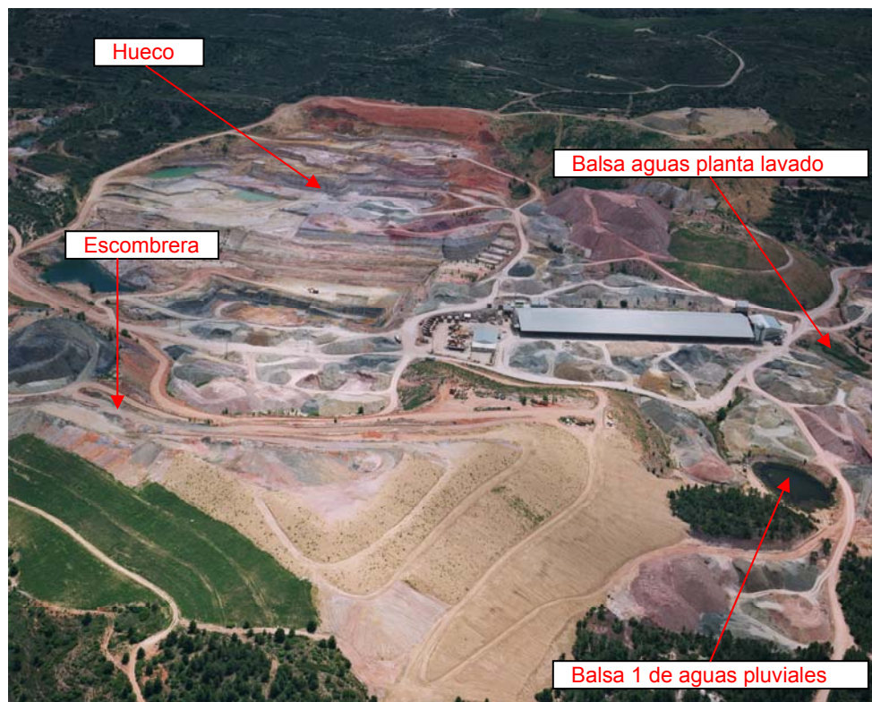
Detalle de la escombrera sur restaurada
