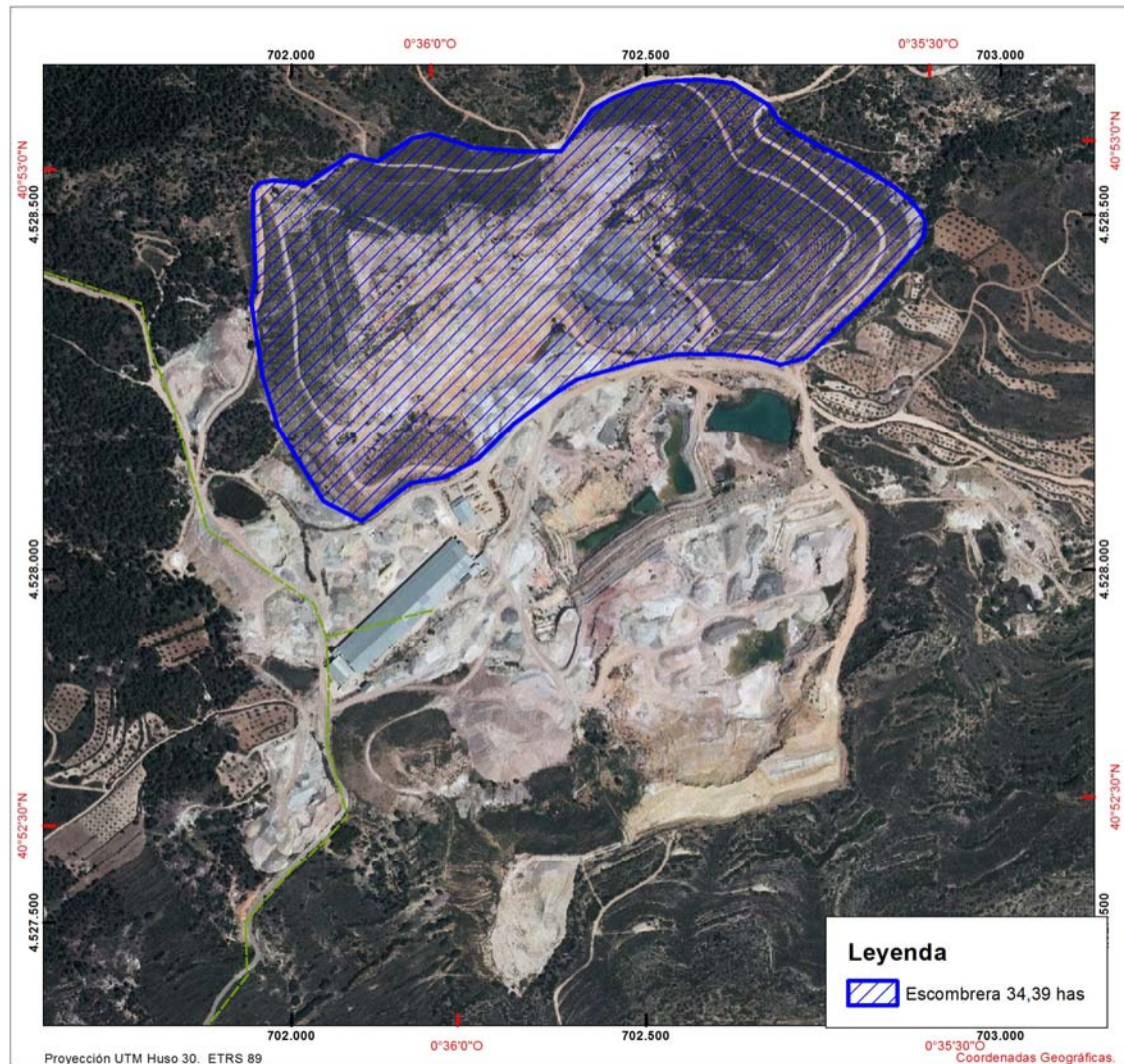
Detalle del emplazamiento de la escombrera exterior
