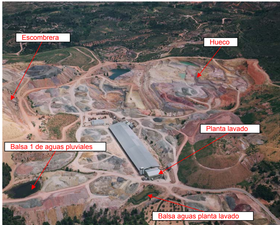
Detalle de la escombrera norte
