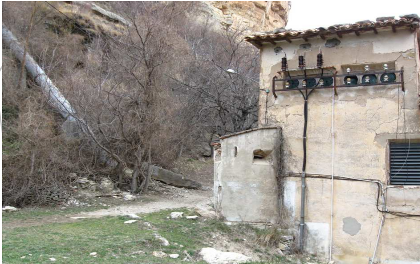
Antigua central hidroeléctrica con garita protección Maquis
