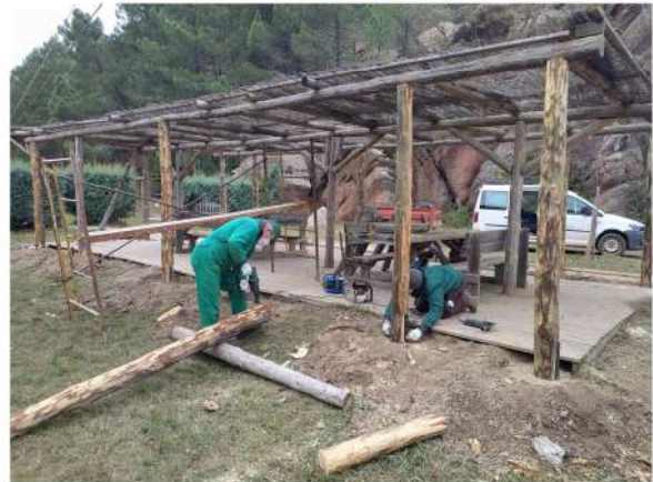
Sustitución de rollizos en mesas cubiertas en Fuente Buena.
