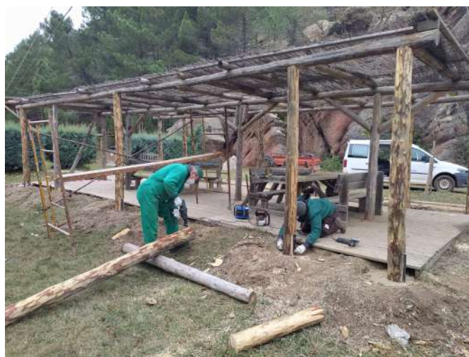
Sustitución de rollizos en mesas cubiertas en Fuente Buena.
