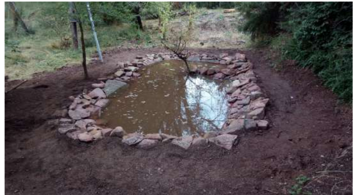
Balsa terminada y llenada
