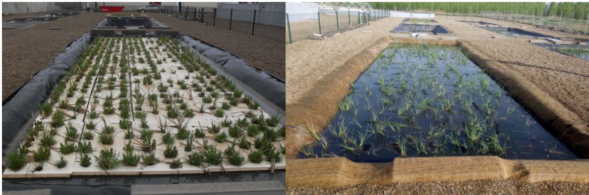
Ilustración 14. (Izq.) Sistema de flotación con poliestireno perforado. (Dcha.) Sistema de flotación que consiste en una manta de arpillera.
