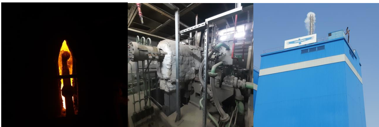
Quemador de Licor Negro y turbina de vapor de TORRASPAPEL. Fotos: TORRASPAPEL
