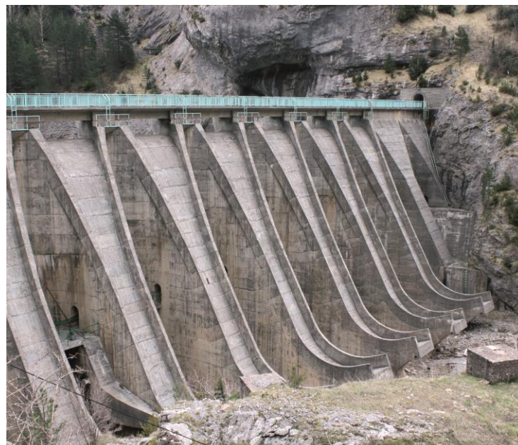
Presa. Central hidroeléctrica de IP. Canfranc
