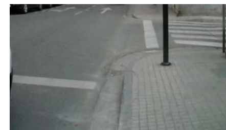
Pavimento de baldosa hidráulica en el vial y terrazo en el tramo coincidente con la plaza Mayor.
