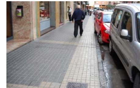
Pavimentos de varios tipos: terrazo y baldosa de dos colores. Alcorques en mal estado y sin protección.
