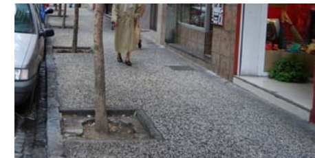
Pavimentos de varios tipos: terrazo y baldosa de dos colores. Alcorques en mal estado y sin protección.
