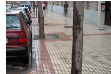
Pavimentos de distinto material según el tramo: baldosa hidráulica gris o bicolor crema y rojo.
