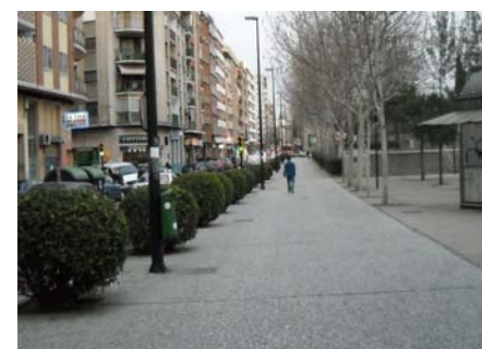
Pavimento de baldosa hidráulica en el vial y terrazo en el tramo coincidente con la plaza Mayor.
