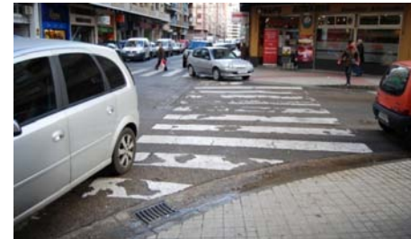
Pavimento de baldosa hidráulica y pintura vial de las calzadas en mal estado.
