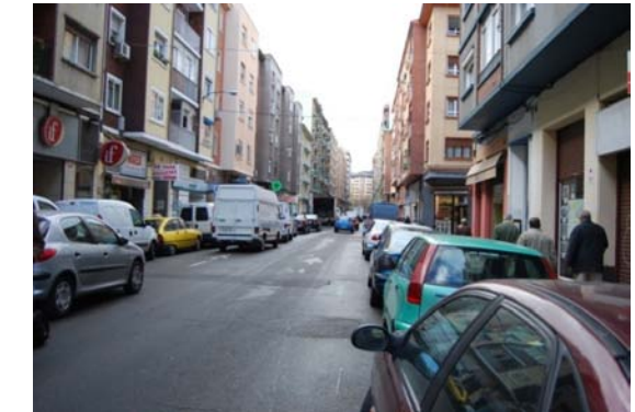
Vial con un nivel de tráfico medio que presenta problemas de aparcamientos irregulares que dificultan el paso.
