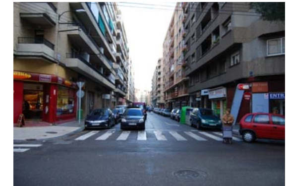
La edificación presenta alturas de 5-7 pisos que ahogan el espacio de la calle, de anchura insuficiente en proporción.
