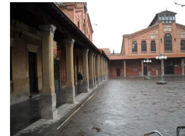
El antiguo matadero, de gran calidad arquitectónica y volumétrica, es hoy el centro cultural Salvador Allende.
