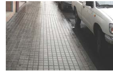
Pavimentos de distinto material según el tramo: baldosa hidráulica gris o bicolor crema y rojo.
