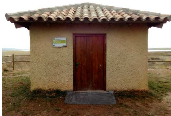
Estado final del observatorio con cubierta y rampa de acceso.
