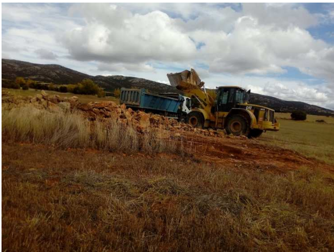
Camión y cargador trabajando en las obras del camino.
