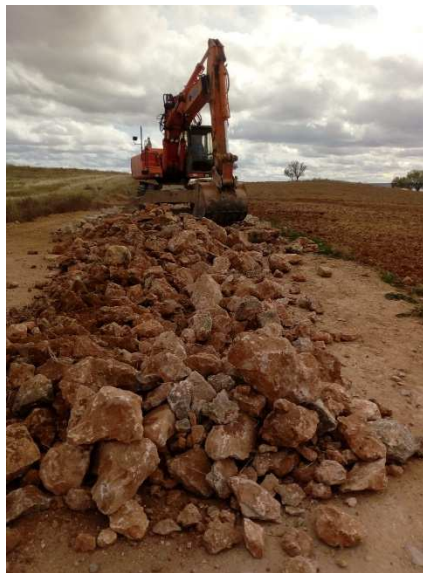
Retro colocando el pedraplén.
