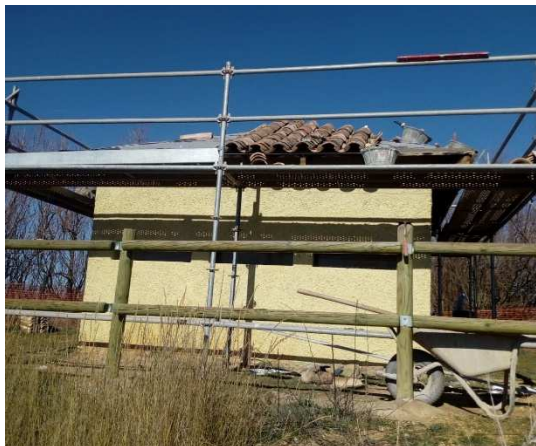
Obras en la cubierta del observatorio.
