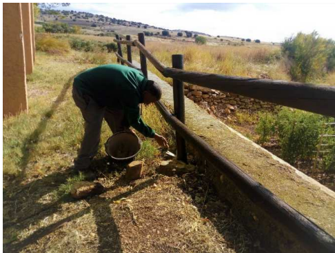
Mantenimiento de vallados en ermita Buen Acuerdo.
