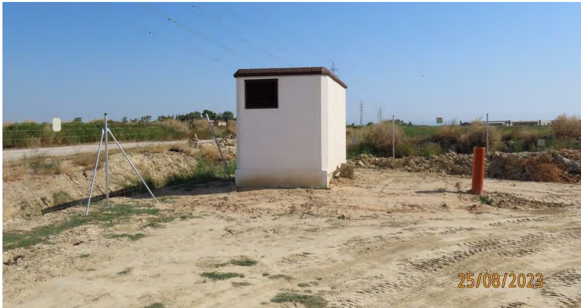
Ilustración 2. Ejecución del centro de seccionamiento.
