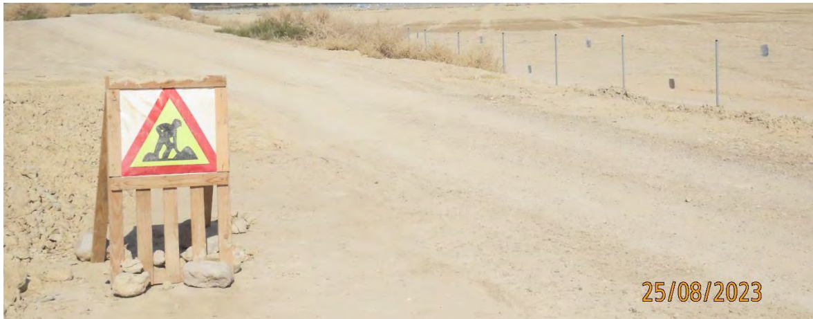
Ilustración 4. Reforzamiento de la señalización de la obra.
