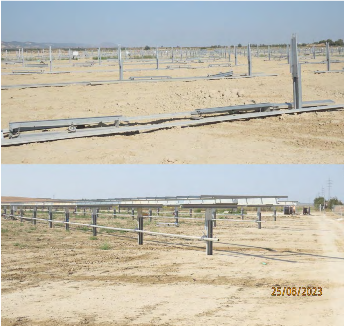
Ilustración 1. Preparación y montaje de las estructuras de los seguidores.
