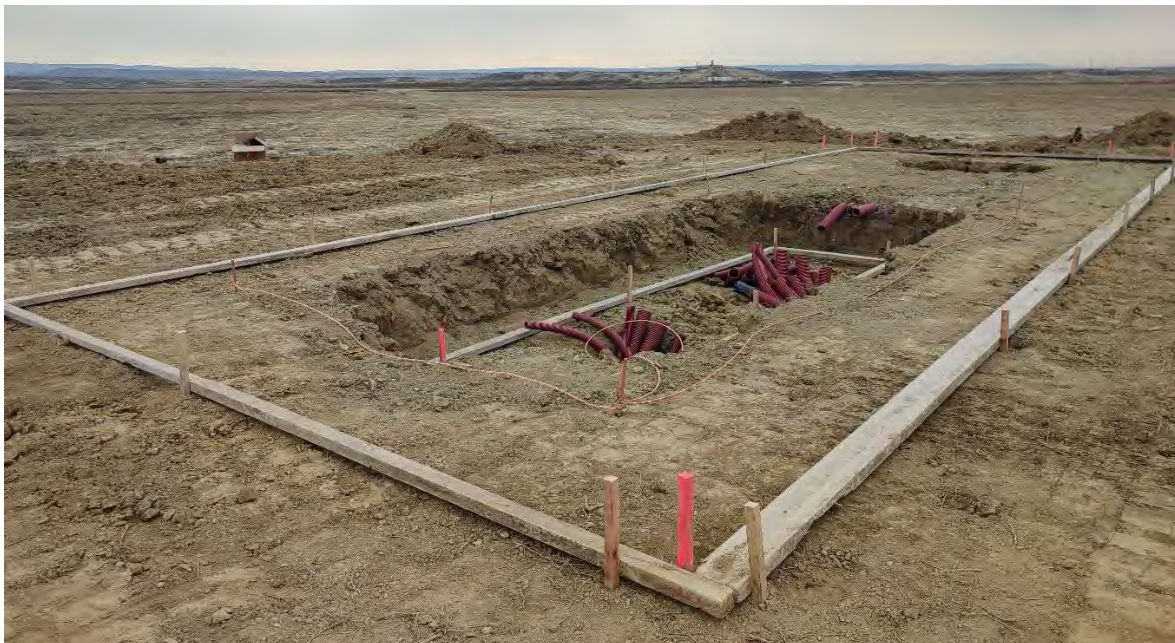
Fotografía 3. Jalonamiento de la base de las Power Station.
