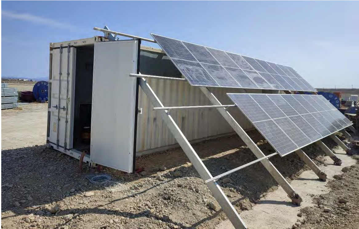
Fotografía 9. Zona de casetas de obra.
