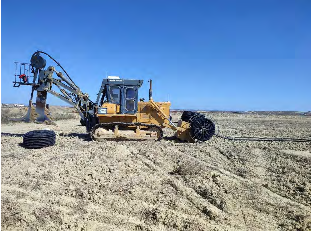
Fotografía 4. Trabajos de zanjadora y colocación de sistema de tuberías.
