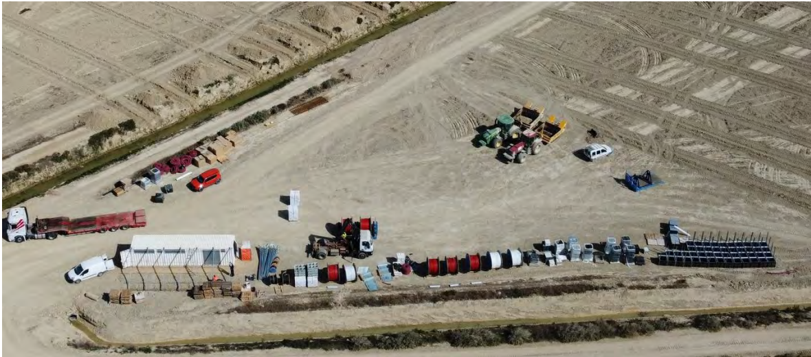
Fotografía 5. Zona de acopio de materiales sobre terreno desprovisto de vegetación natural.
