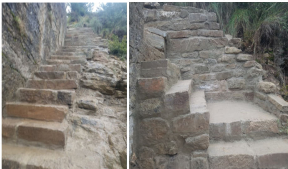
Fotos de la construcción de escaleras en Pozo Pigalo
