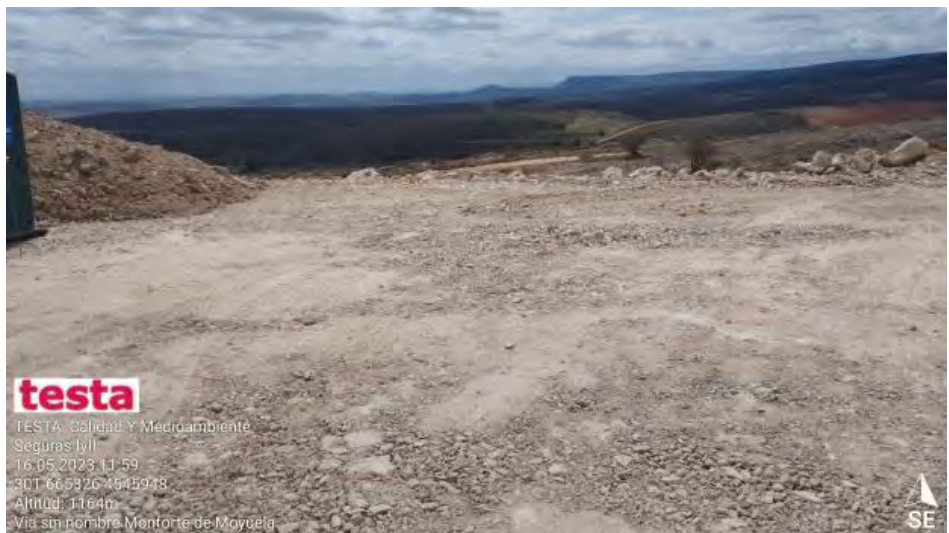
Plataforma SE2-10 sin pozo de lavado
