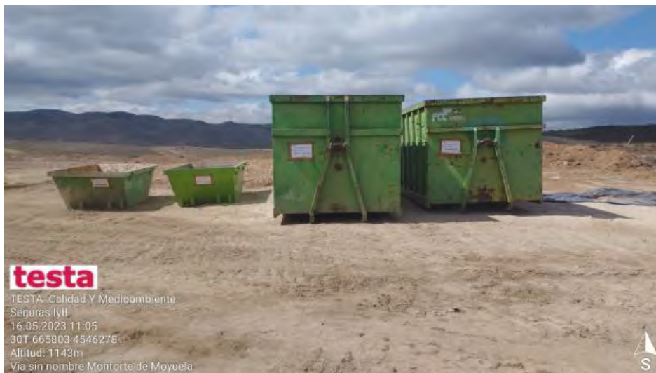
Contenedores de residuos no peligrosos y 1 de hormigon
