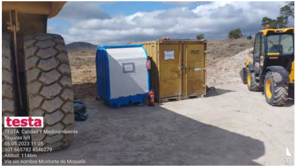
Contenedor Abadía aún en obra
