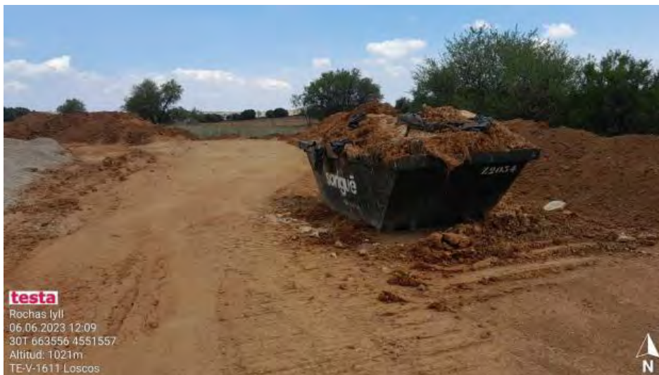
Restauración de pozo y tratamiento de residuos en RH1-3
