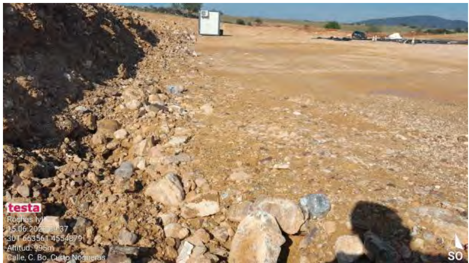
Residuos en plataforma.
